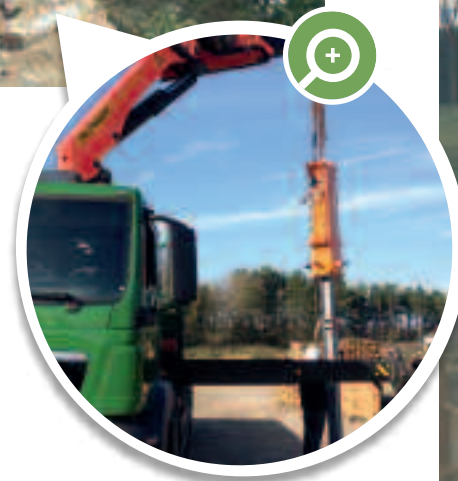
Battage de pieux métalliques par batteur hydraulique
