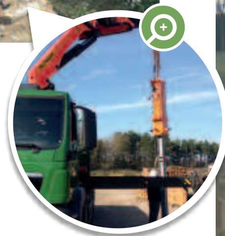
Battage de pieux métalliques par batteur hydraulique
